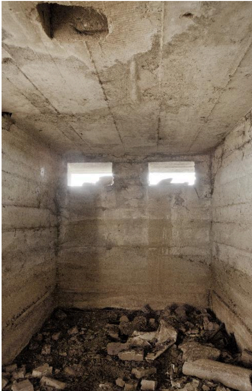
Vue intérieure vers le sud
