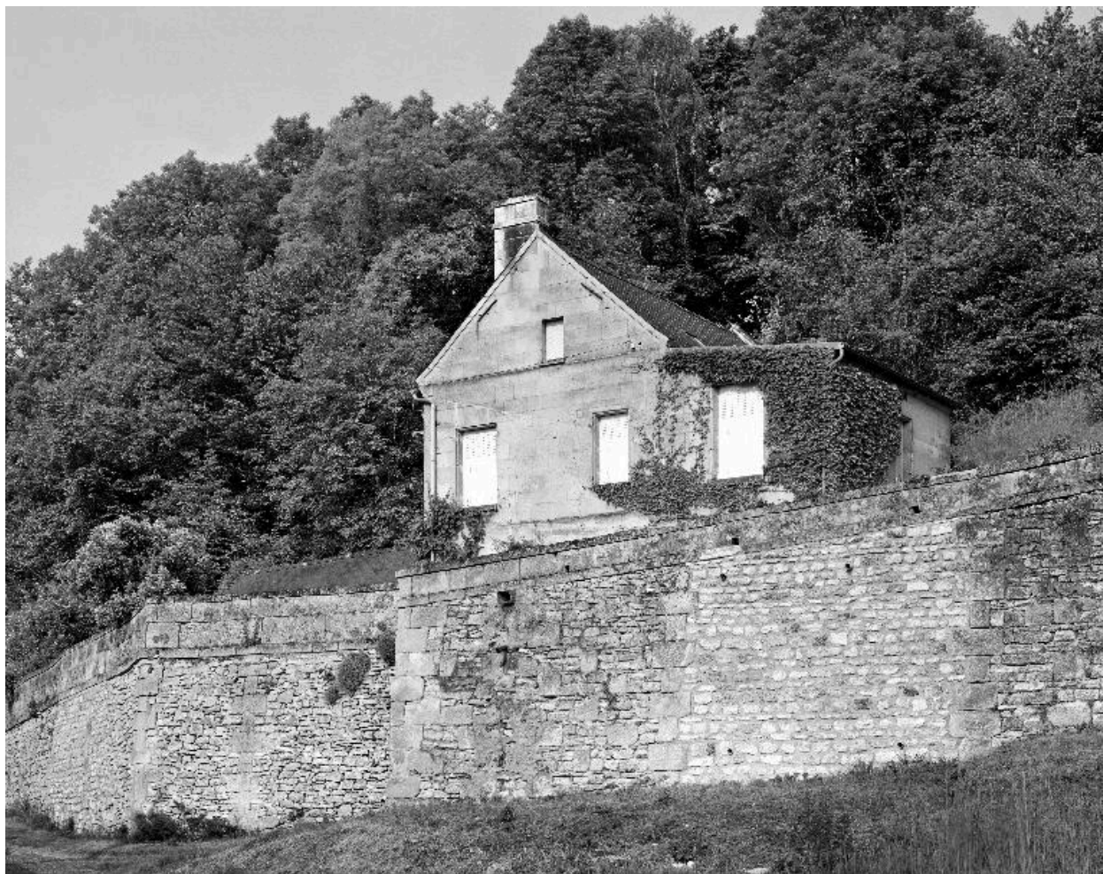
Maison, 4 rue de l'Église : vue depuis le nord-est.
