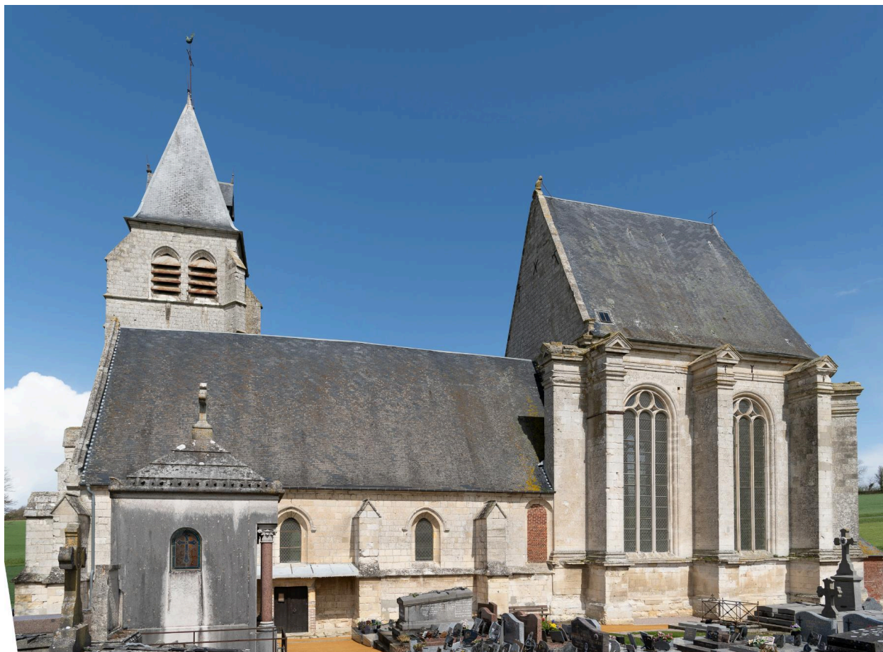
Vue générale de l'élévation sud.
