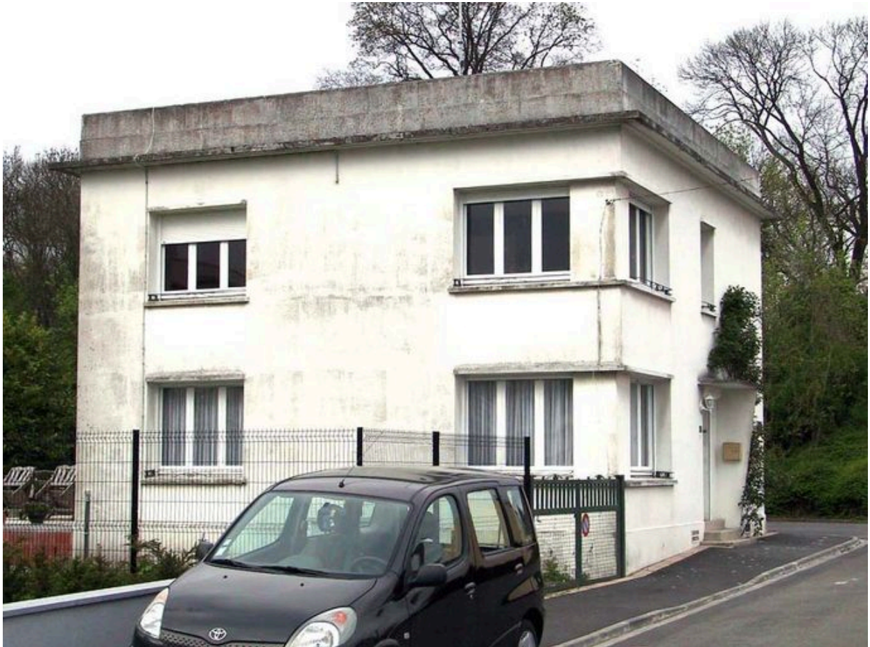
Logement de fonction, vue générale.
