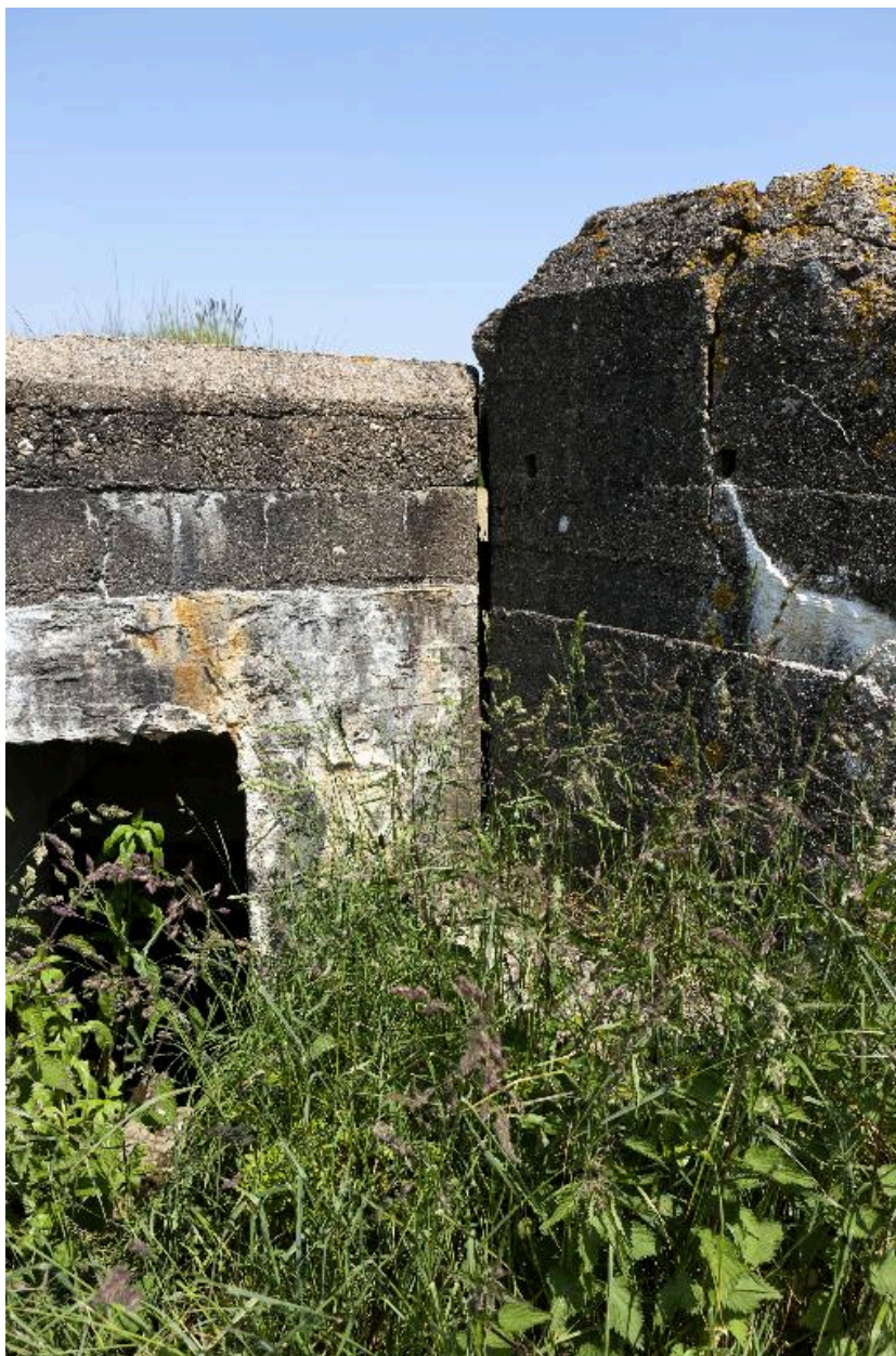
Jonction de l'abri avec l'observatoire casematé
