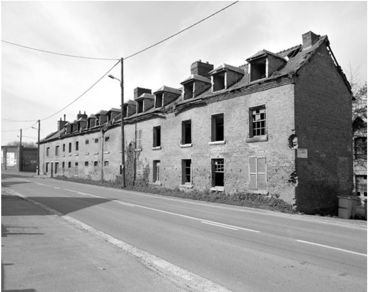
Logements ouvriers, élévation antérieure.
