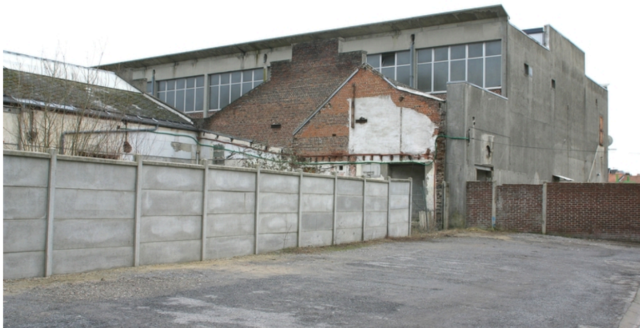
Façade postérieure des ateliers de 1950.
