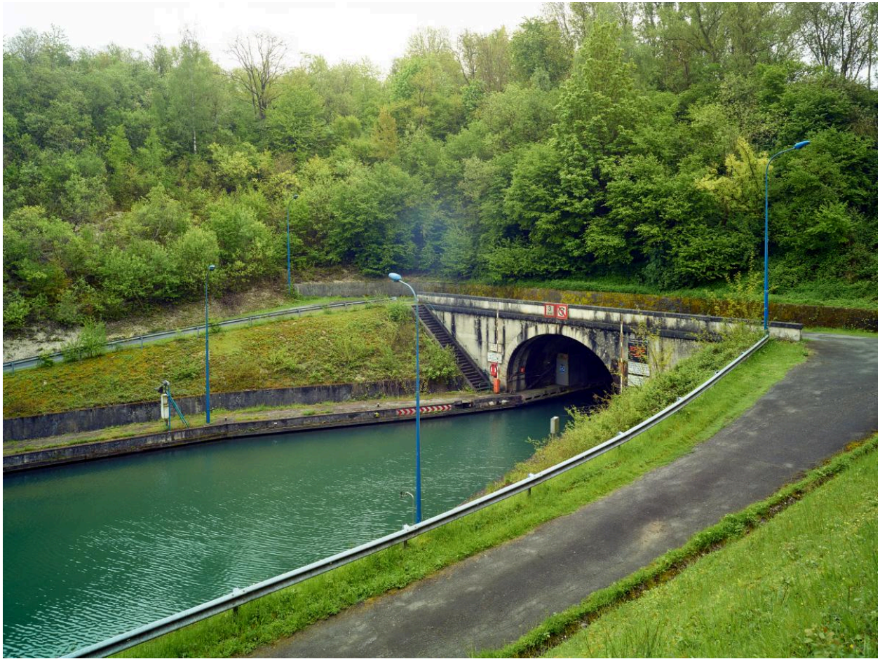
Tête nord et voie de circulation.
