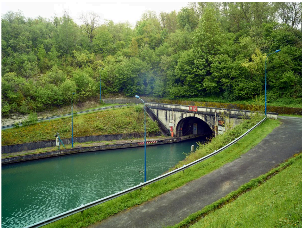
Tête nord et voie de circulation.
