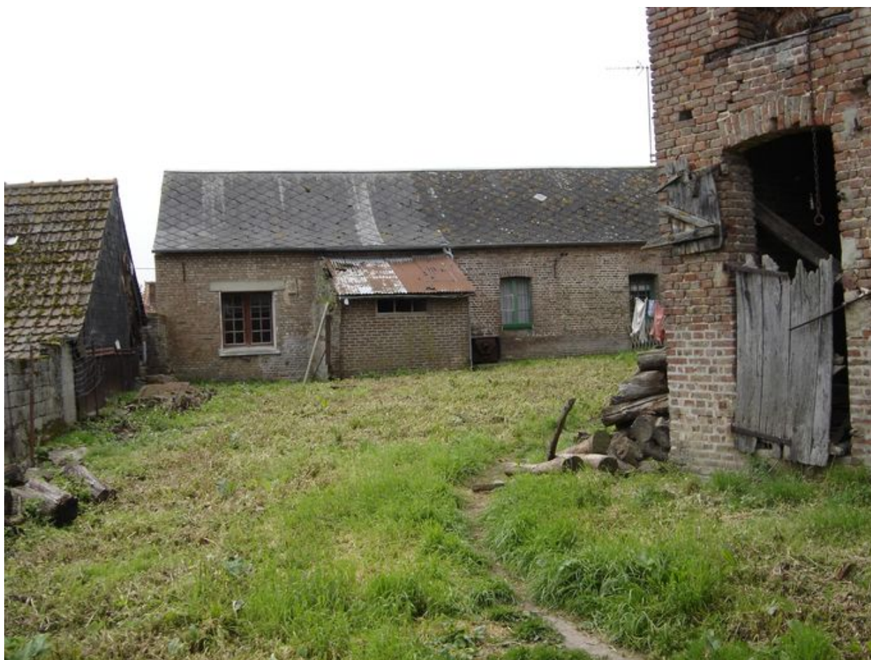
Vue postérieure du logis.
