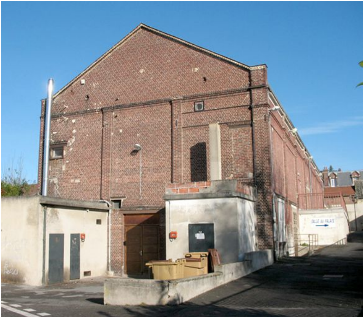
Bâtiment de la salle des fêtes.
