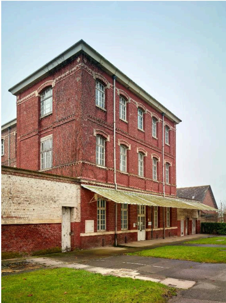
Bâtiment d'hospitalisation dit pavillon 6, élévation latérale donnant sur l'espace médian constituant l'axe de l'établissement, vue de trois quarts gauche.
