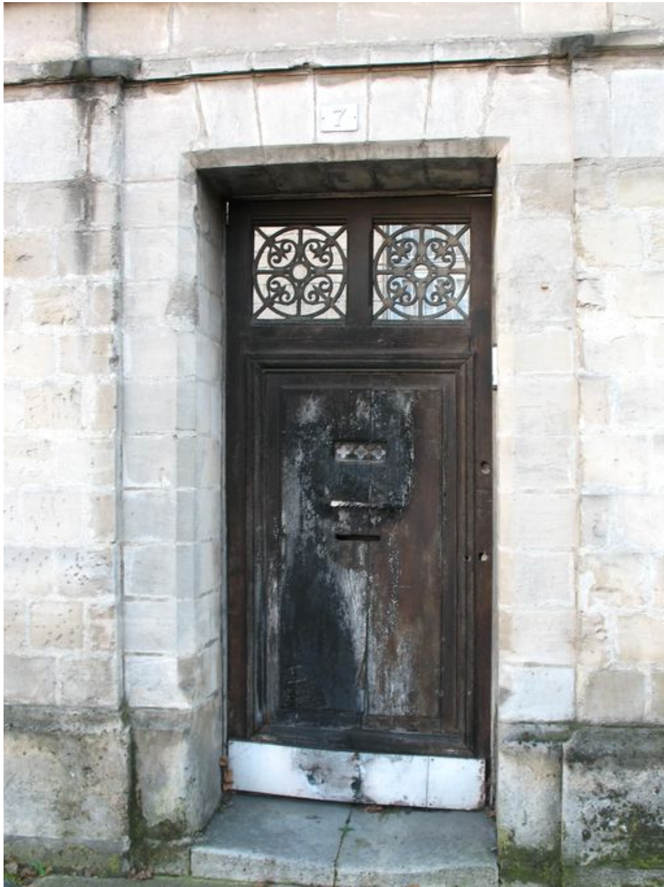
Porte d'entrée des bureaux.
