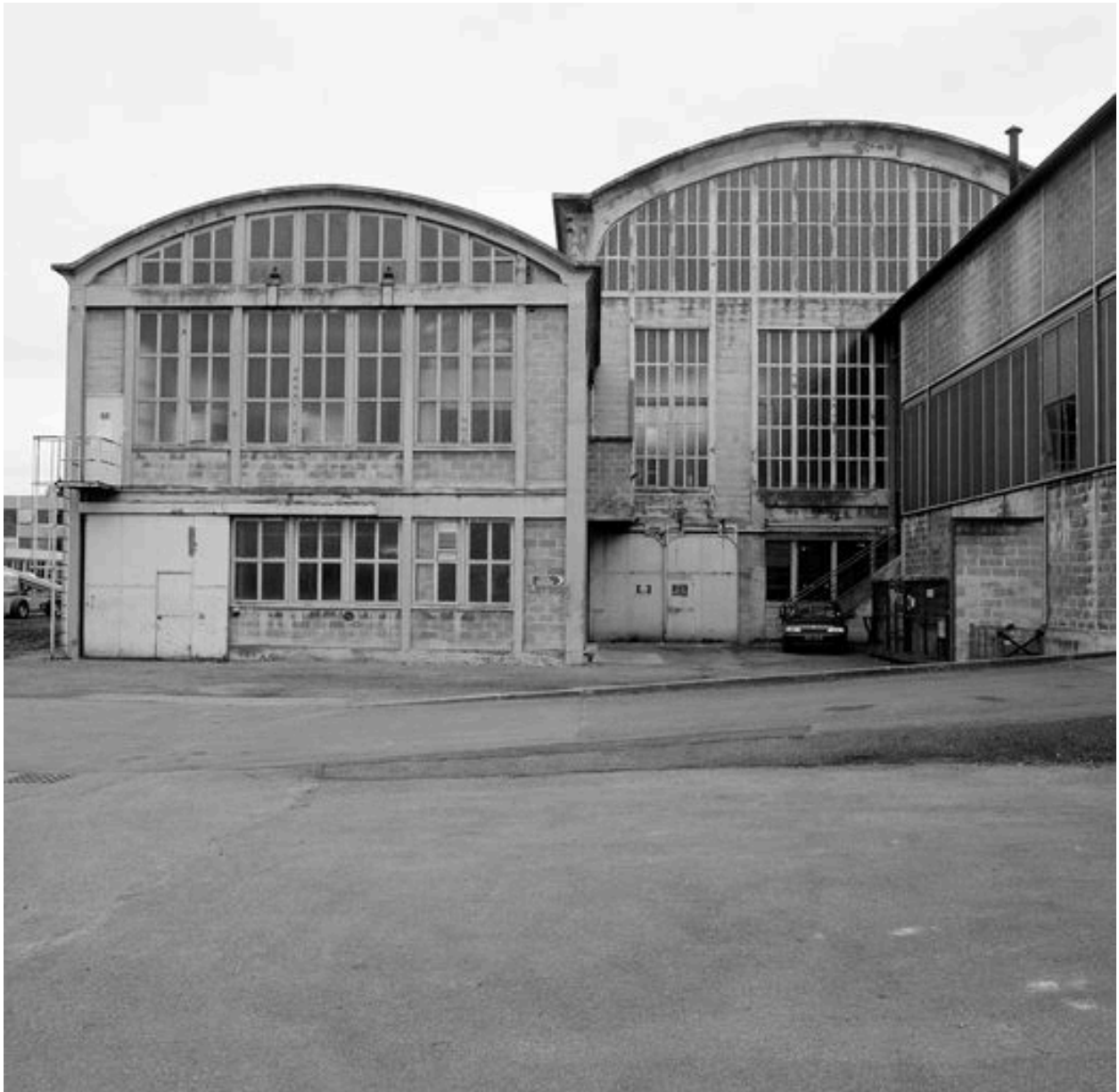
Pignon du bâtiment de l'ancienne ligne de fabrication, construit en 1922-1923.
