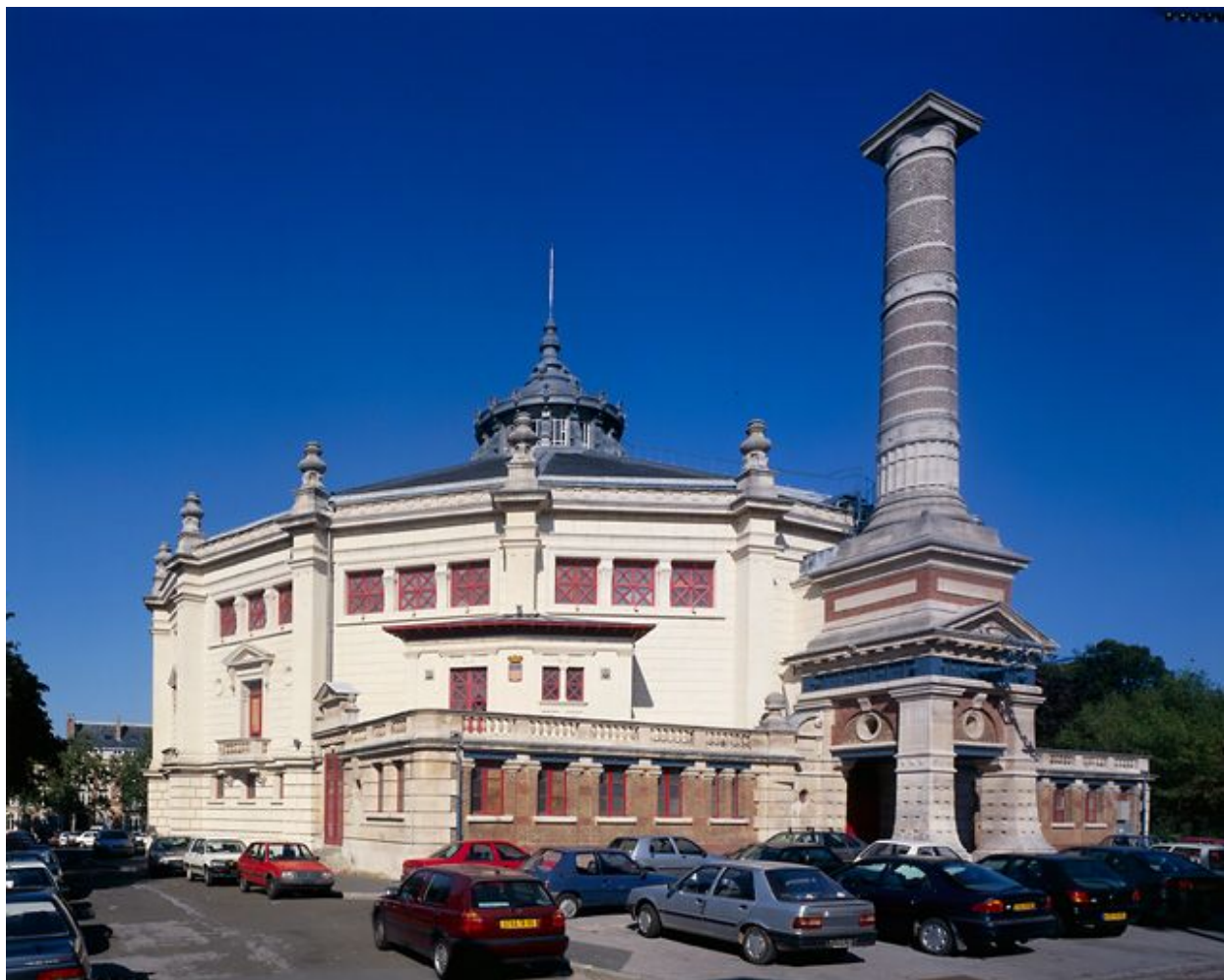
Vue de l'élévation postérieure avec la cheminée.
