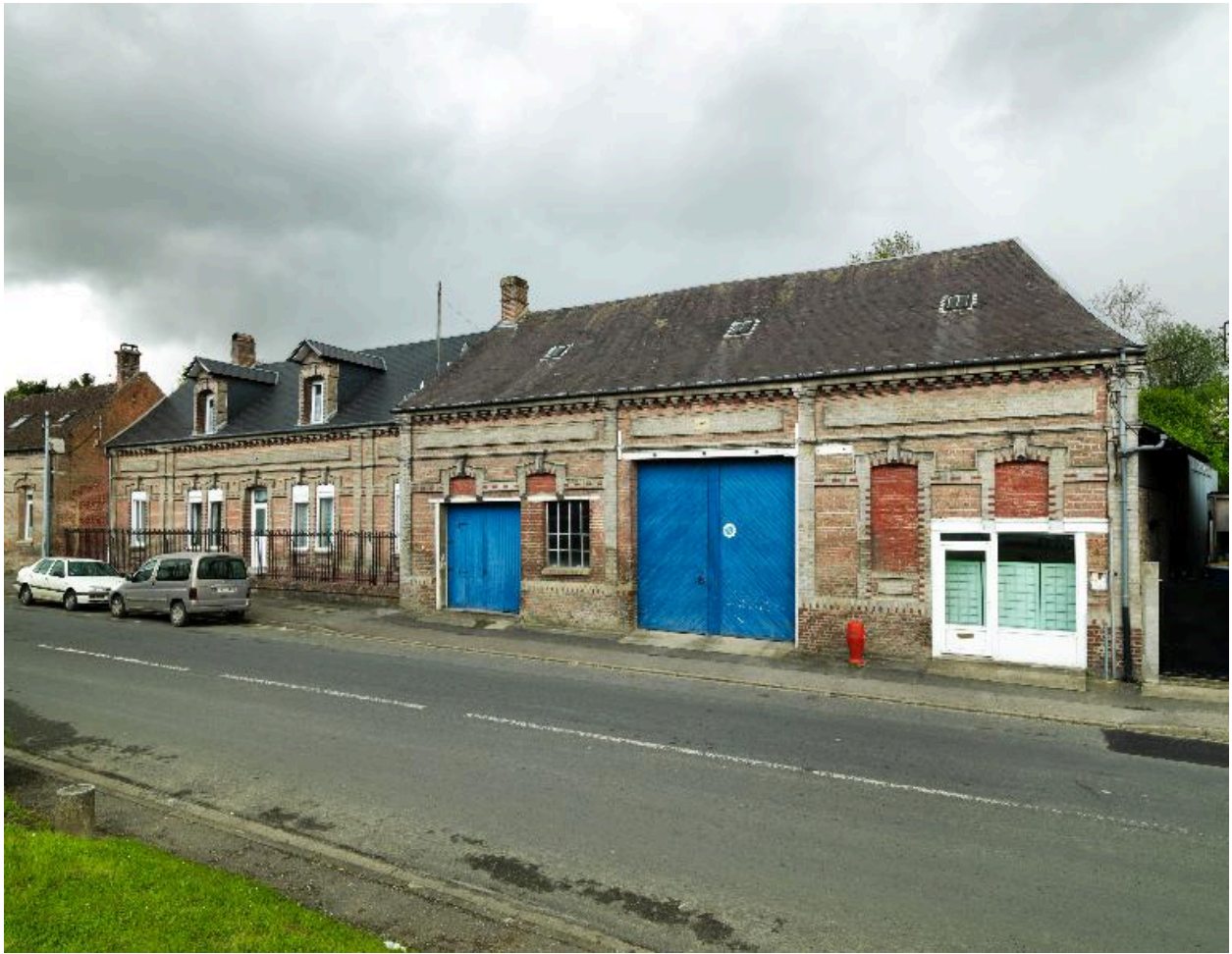
Vue d'ensemble sur rue.
