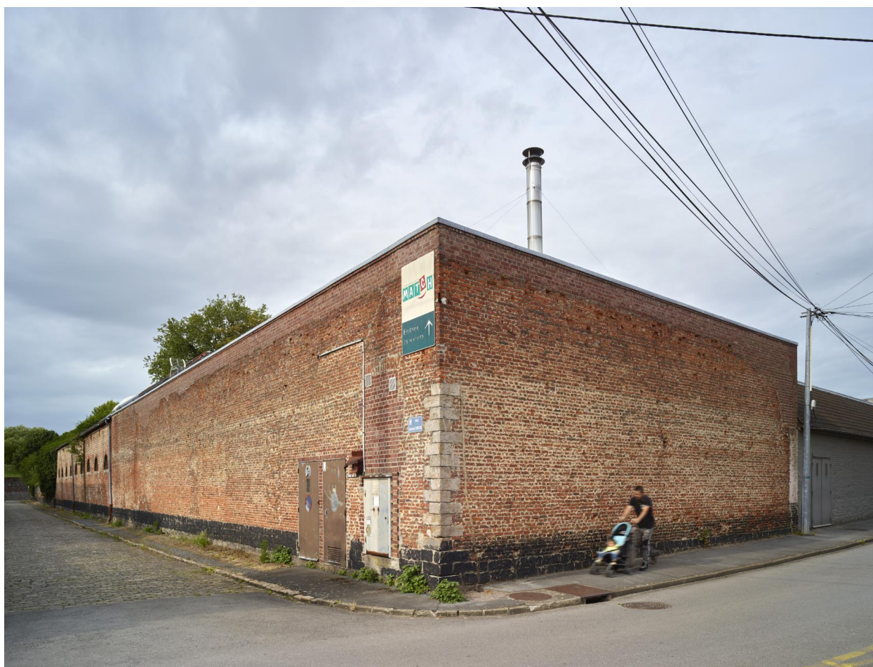
Vestige du mur d'enceinte du premier arsenal (actuellement, rue Beaudoin-l'Edifieur).
