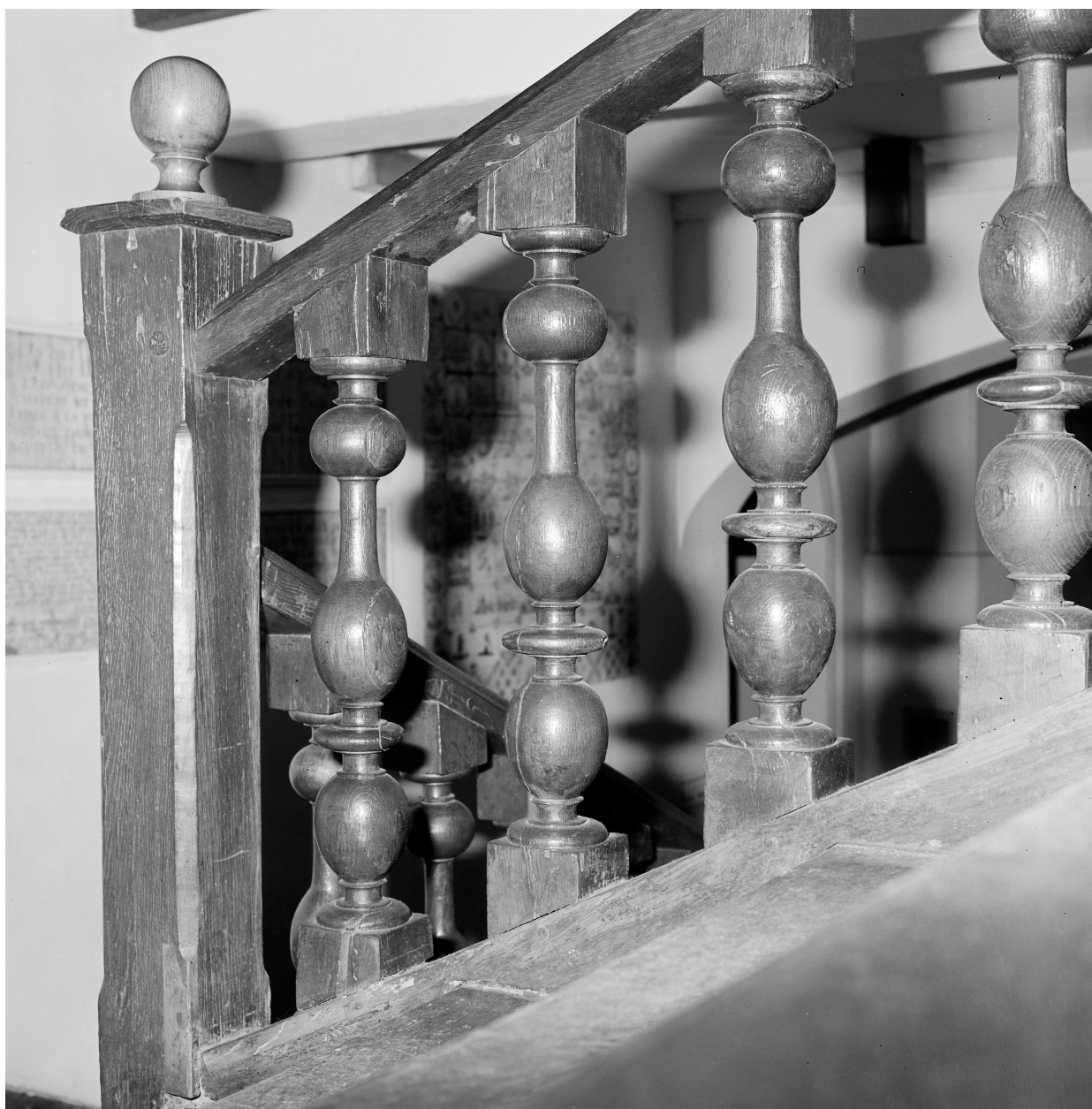
Corps central, escalier d'honneur, rampe : détail.
