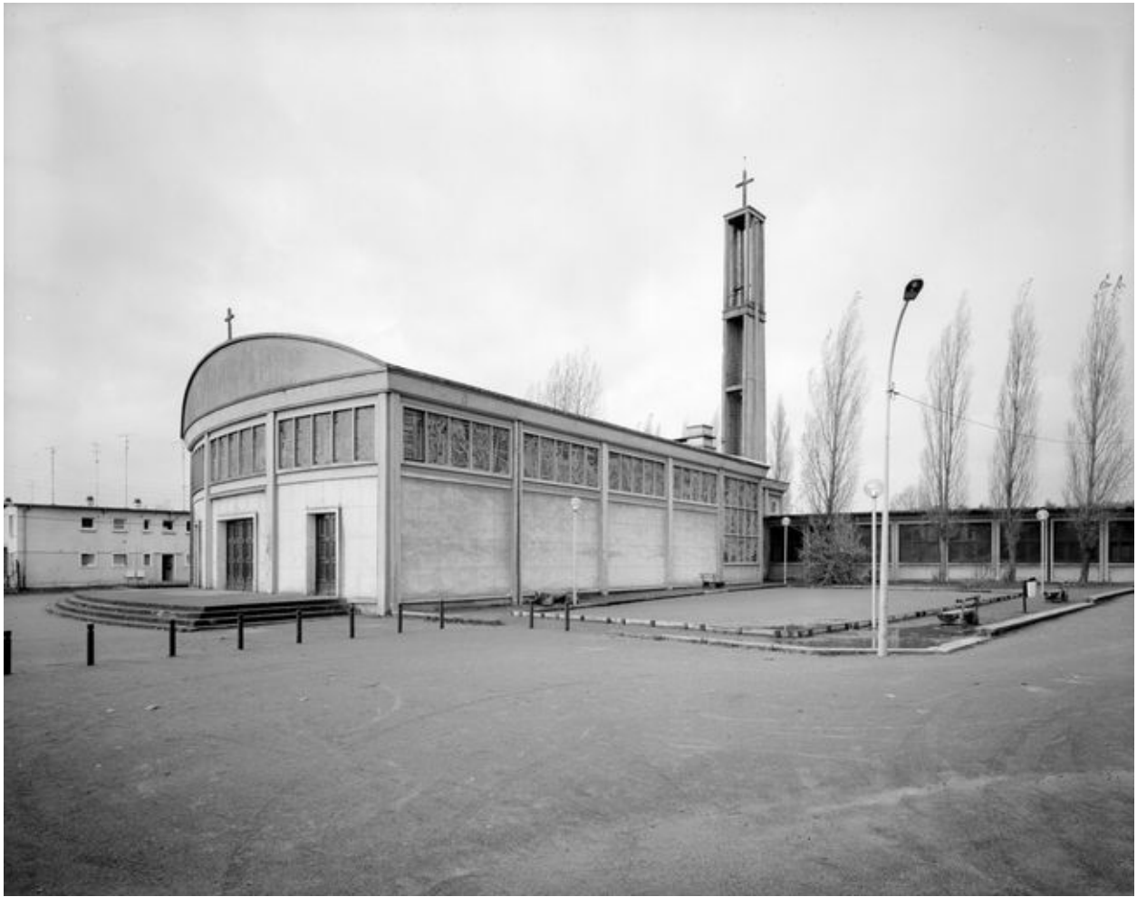
Vue des façades sud et est.
