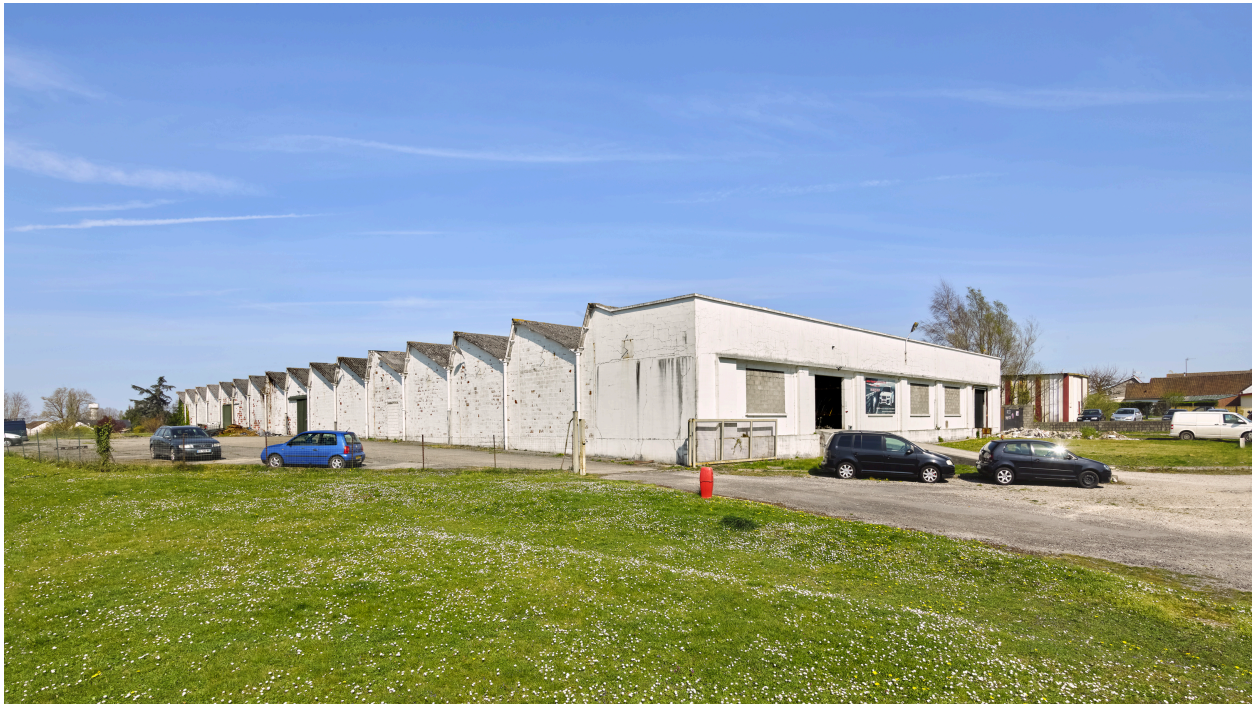
Vue du bâtiment d'usine des années 1960, depuis le sud.
