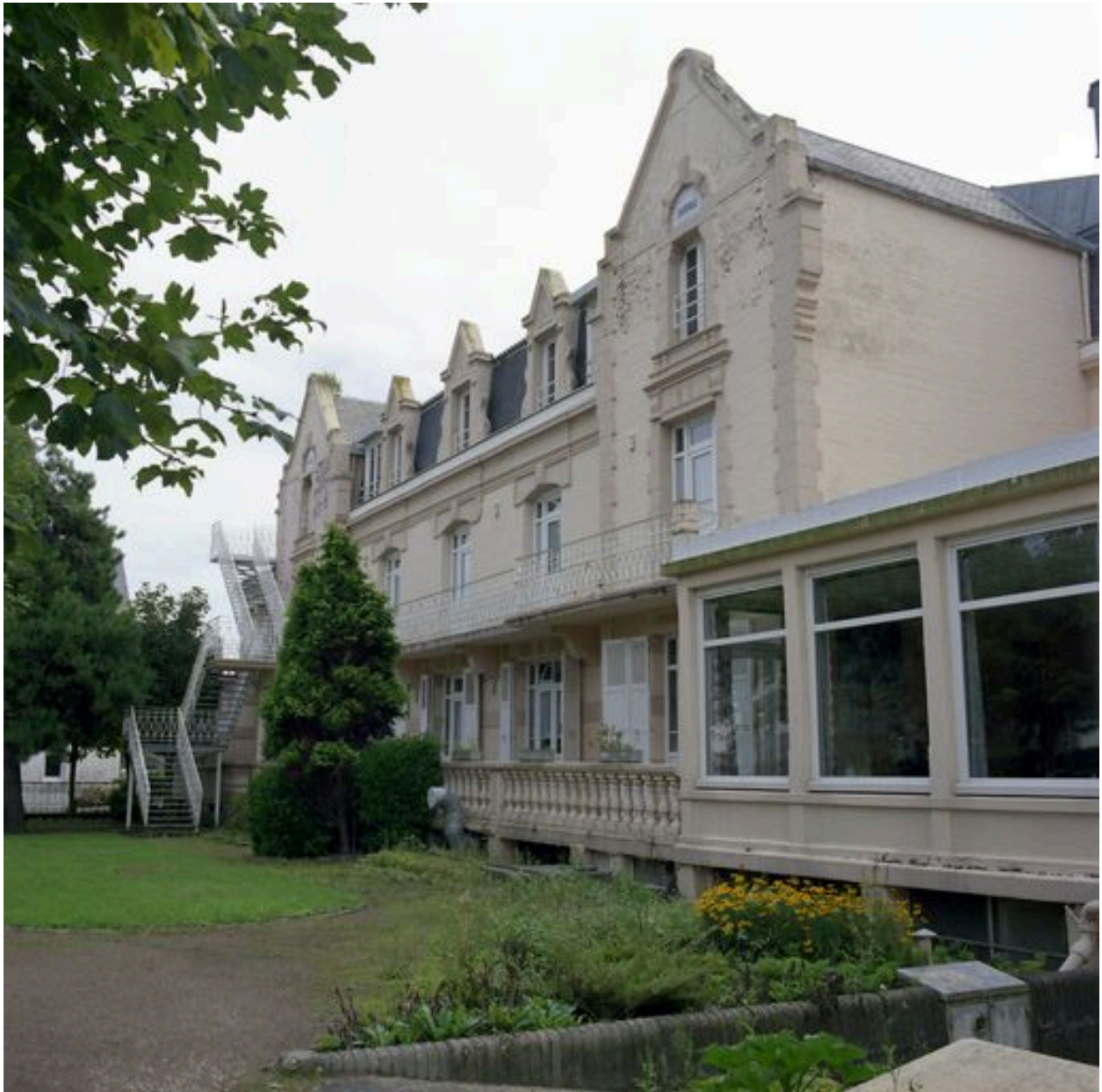
Elévation du bâtiment ajouté en 1906-1907 le long de la rue Lhomel, vue en enfilade.
