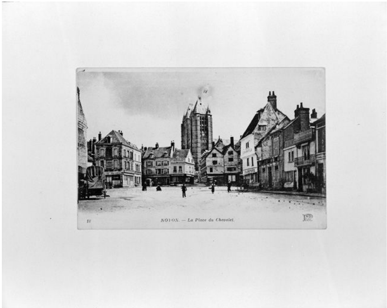
Place Aristide-Briand, vers le nord. Avant 1914 (AP).
