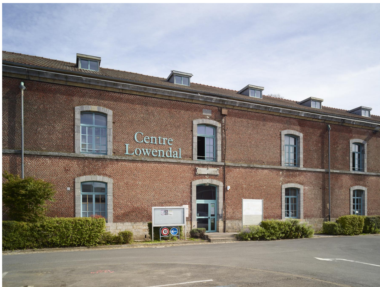
Ancienne caserne Lowendal : détail d'un module de trois travées.
