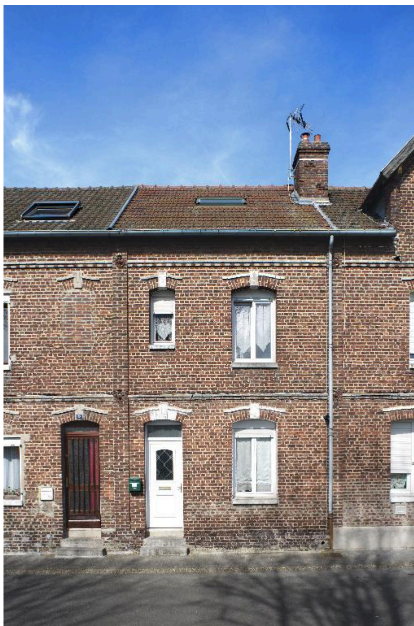
Façade sur rue d'un logement (7, place de la Raffinerie).
