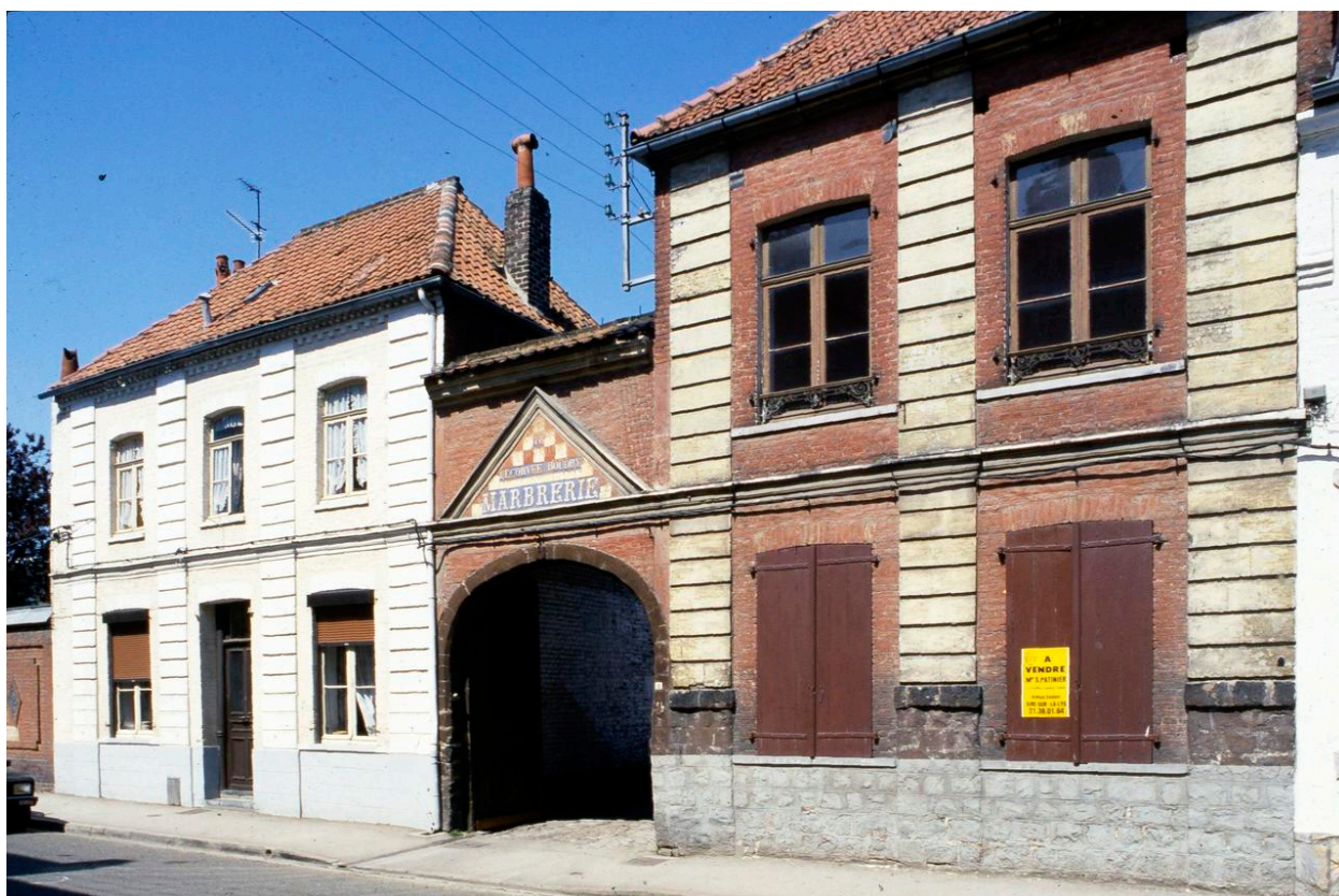
Ensemble des bâtiments donnant sur la rue du Château.
