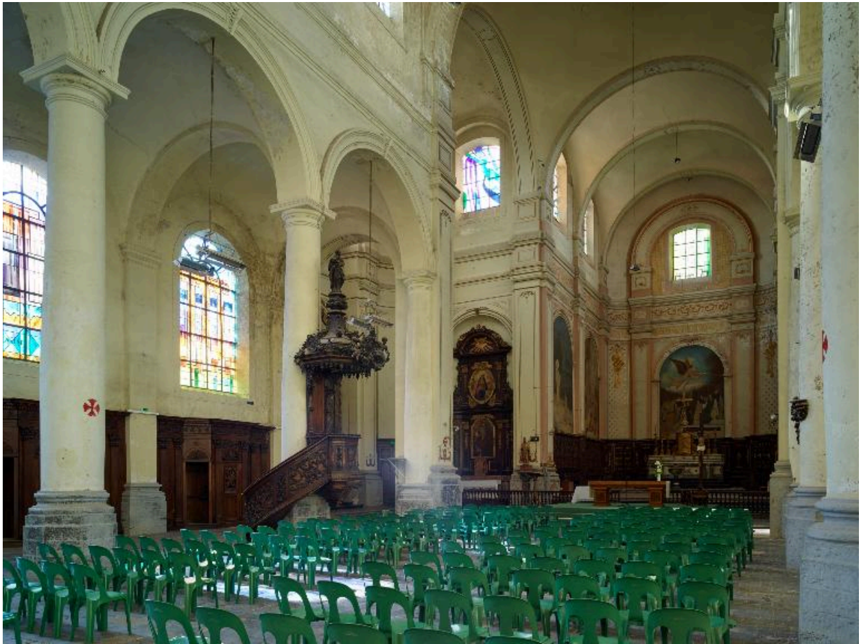
Vue générale de trois quarts des grandes arcades de la nef, le transept non saillant et le chœur à chevet plat.
