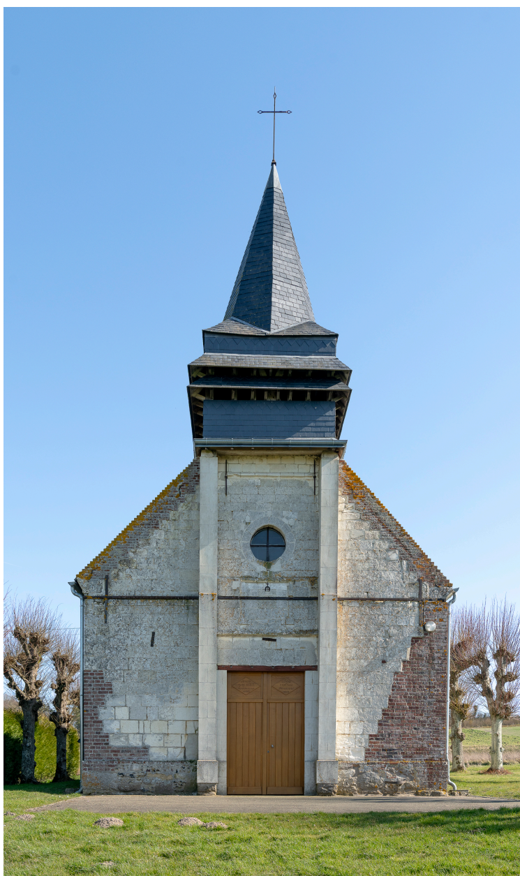
Vue générale de la façade occidentale.
