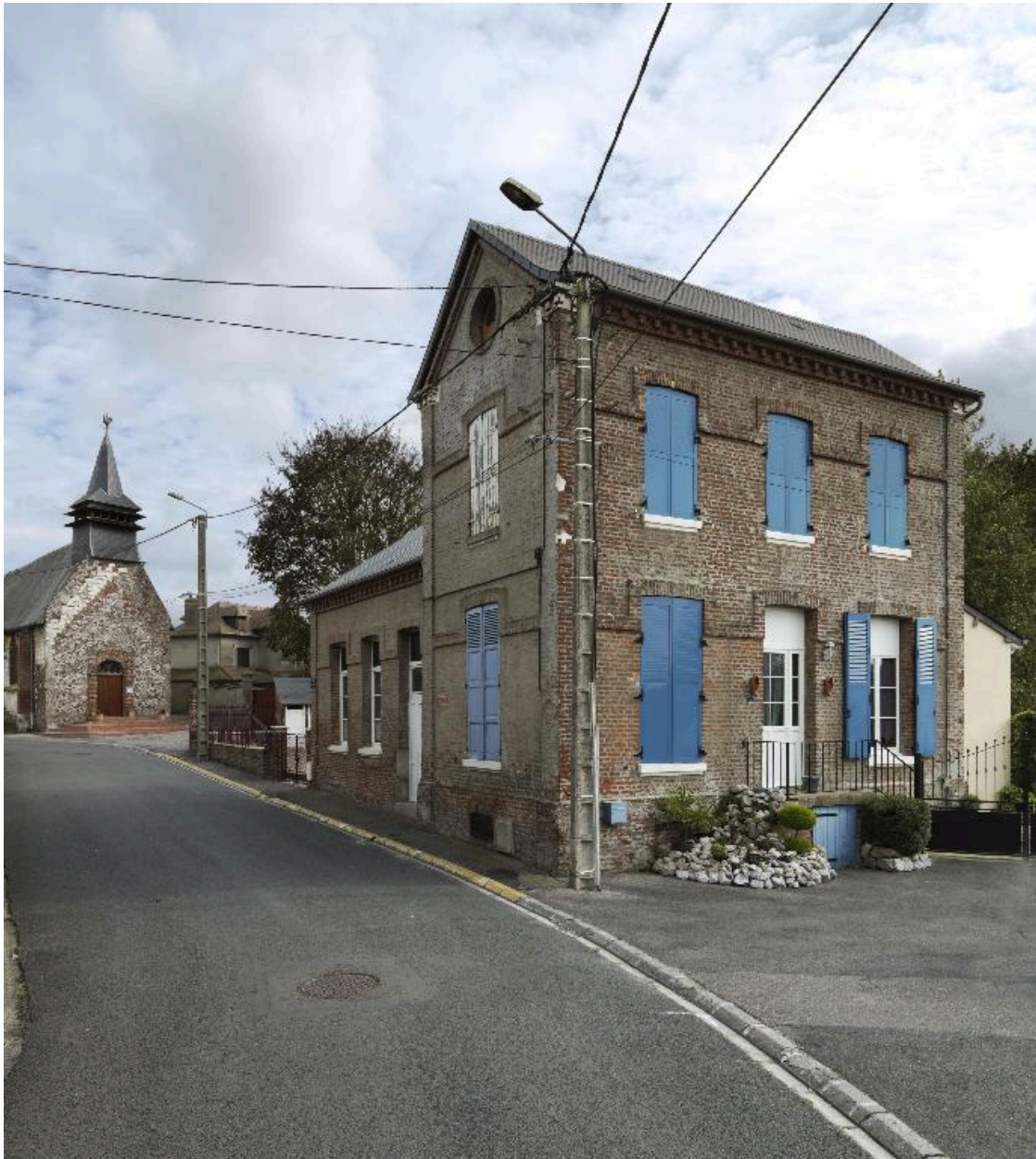
Ancienne école des filles, allée des Ecoliers.
