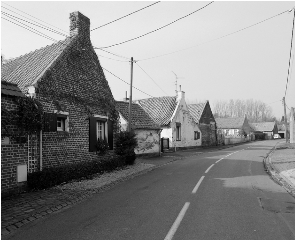
Alignement des fermes rue du Vieux-Condé.
