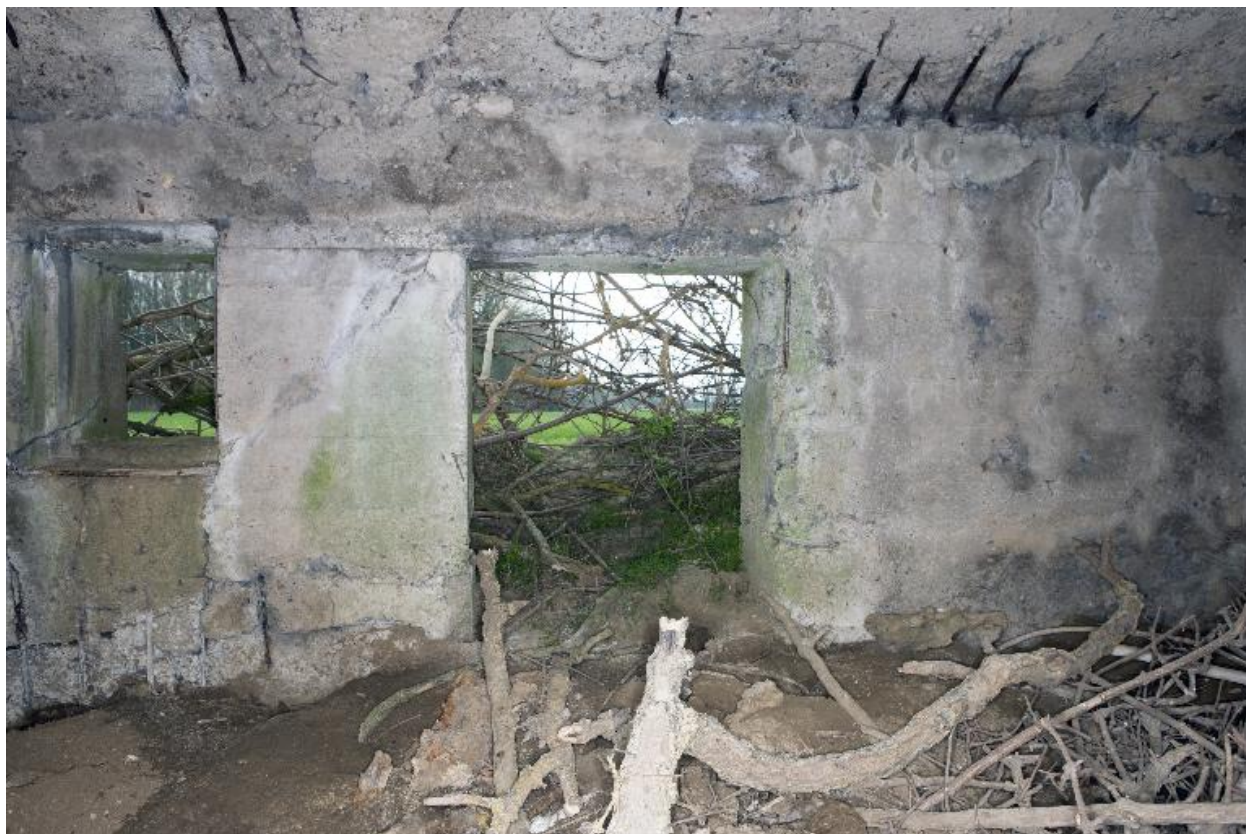
Vue intérieure, salle sud, vers l'est
