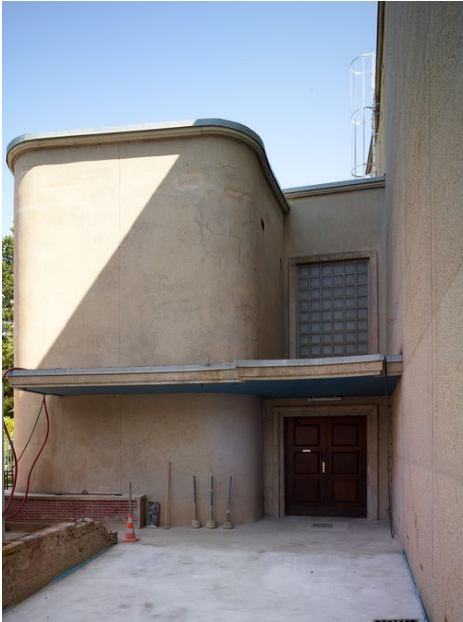
Vue extérieure de l'entrée latérale de l'église.
