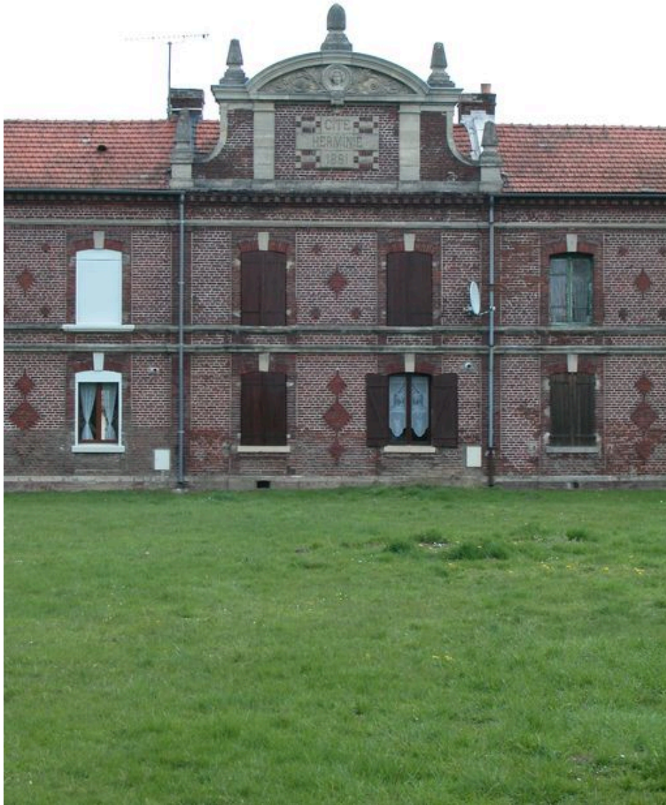
Vue des travées centrales du corps de bâtiment nord, portant le fronton.
