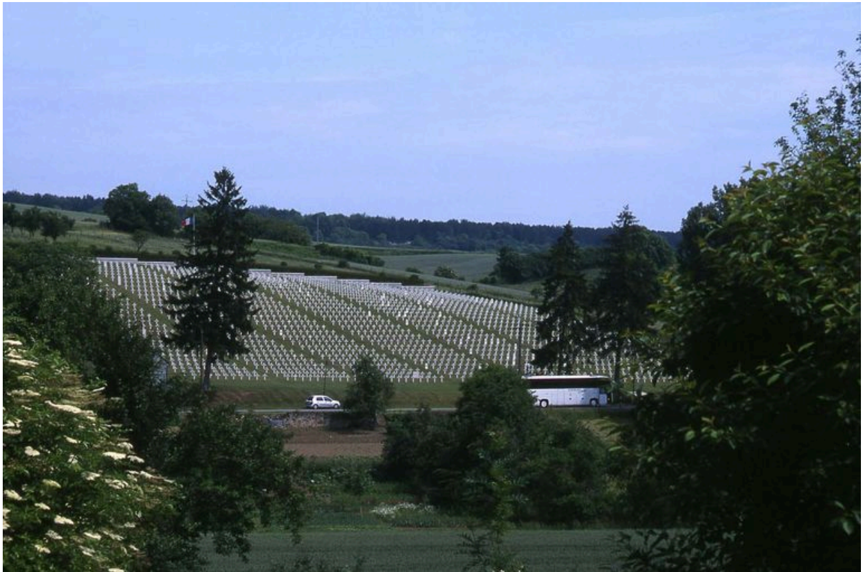
Vue générale du cimetière nationale de Craonnelle.
