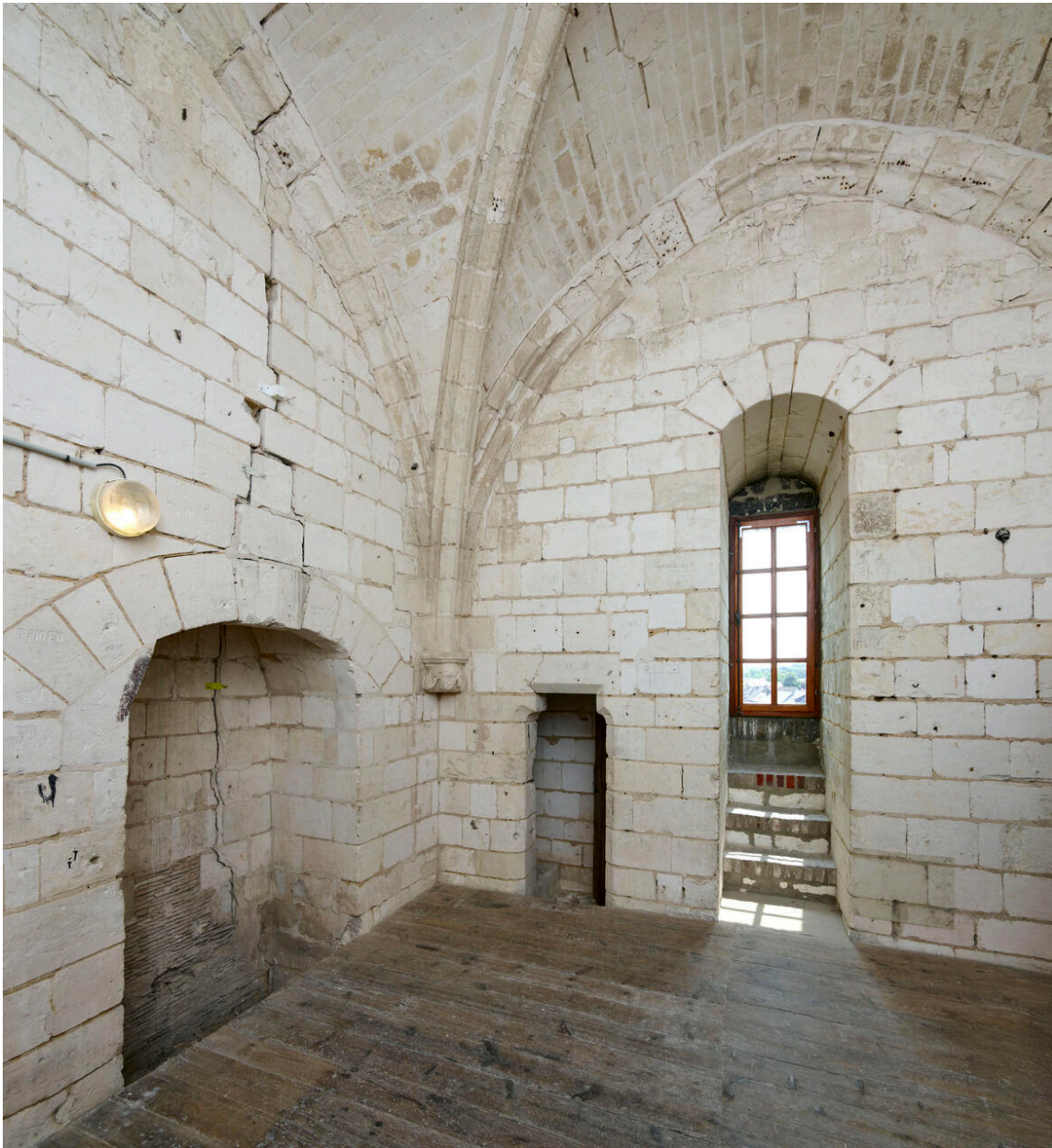
Intérieur de la salle des gardes avec la cheminée à gauche.
