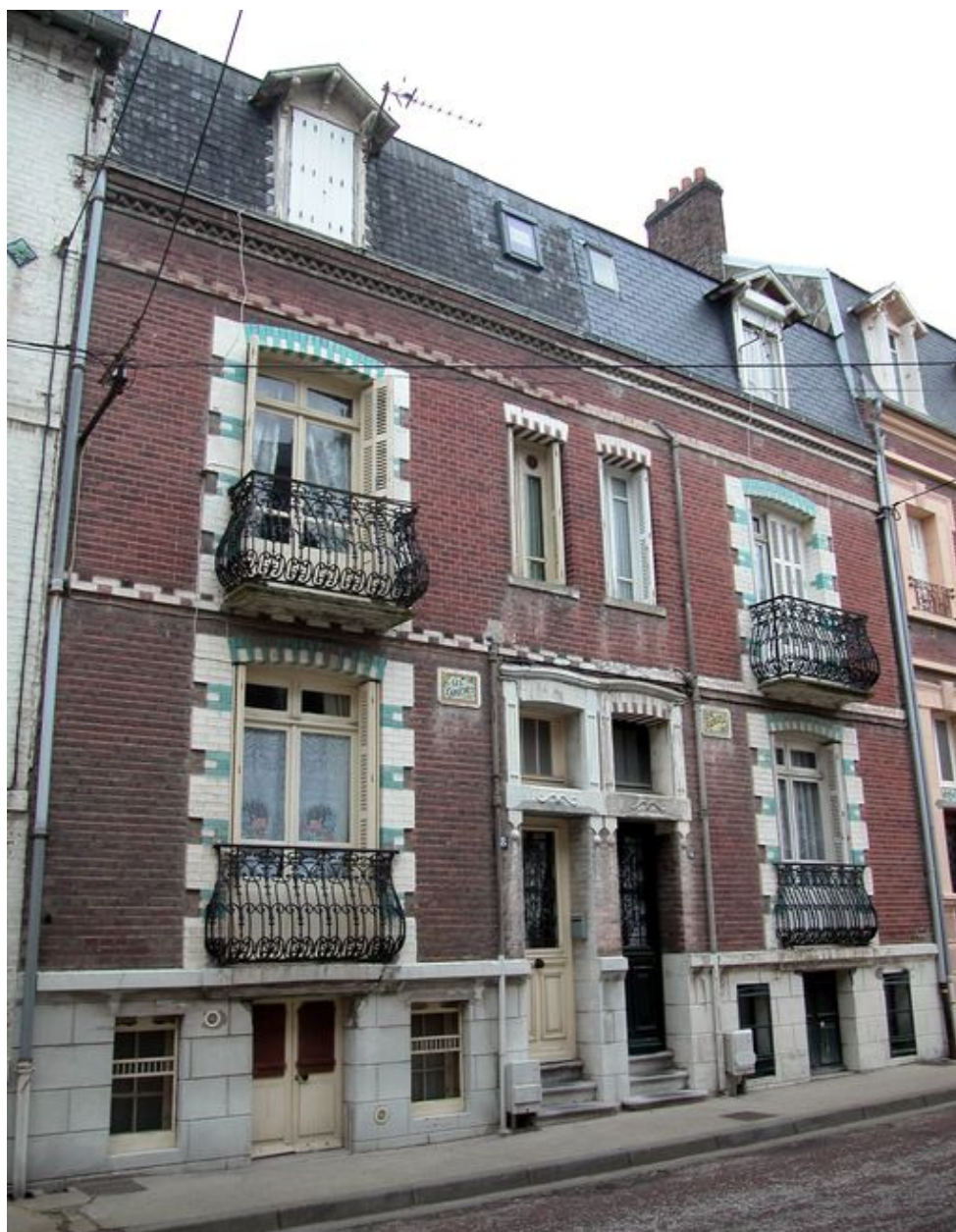
Vue d'ensemble depuis la rue
