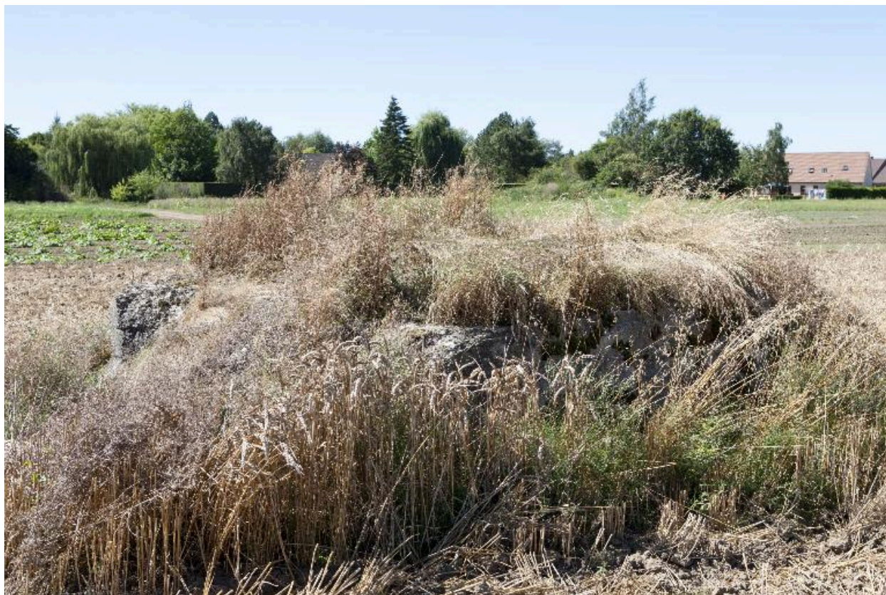
Casemate sud, vers l'ouest
