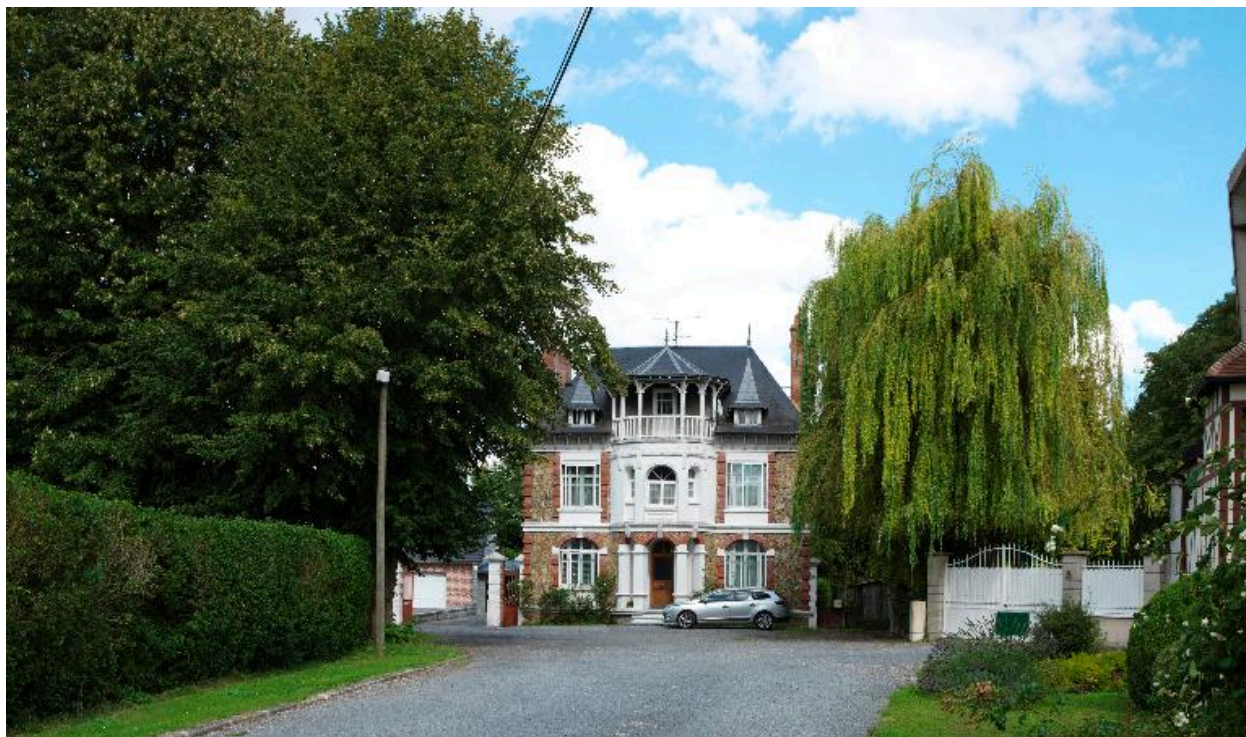
Maison, 35 rue Joliot-Curie.
