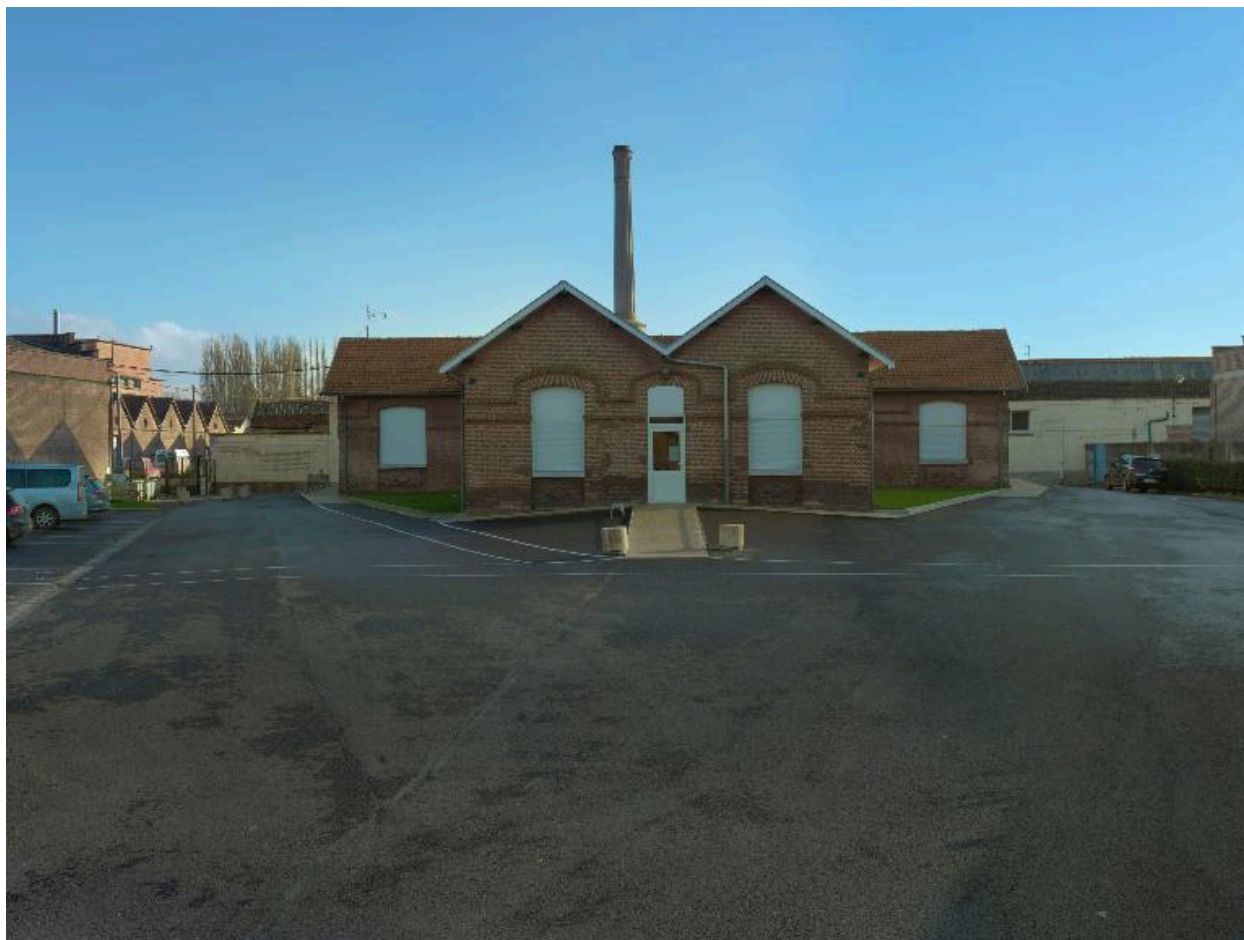
Ancien bâtiment administratif à l'arrière de l'entrée nord.
