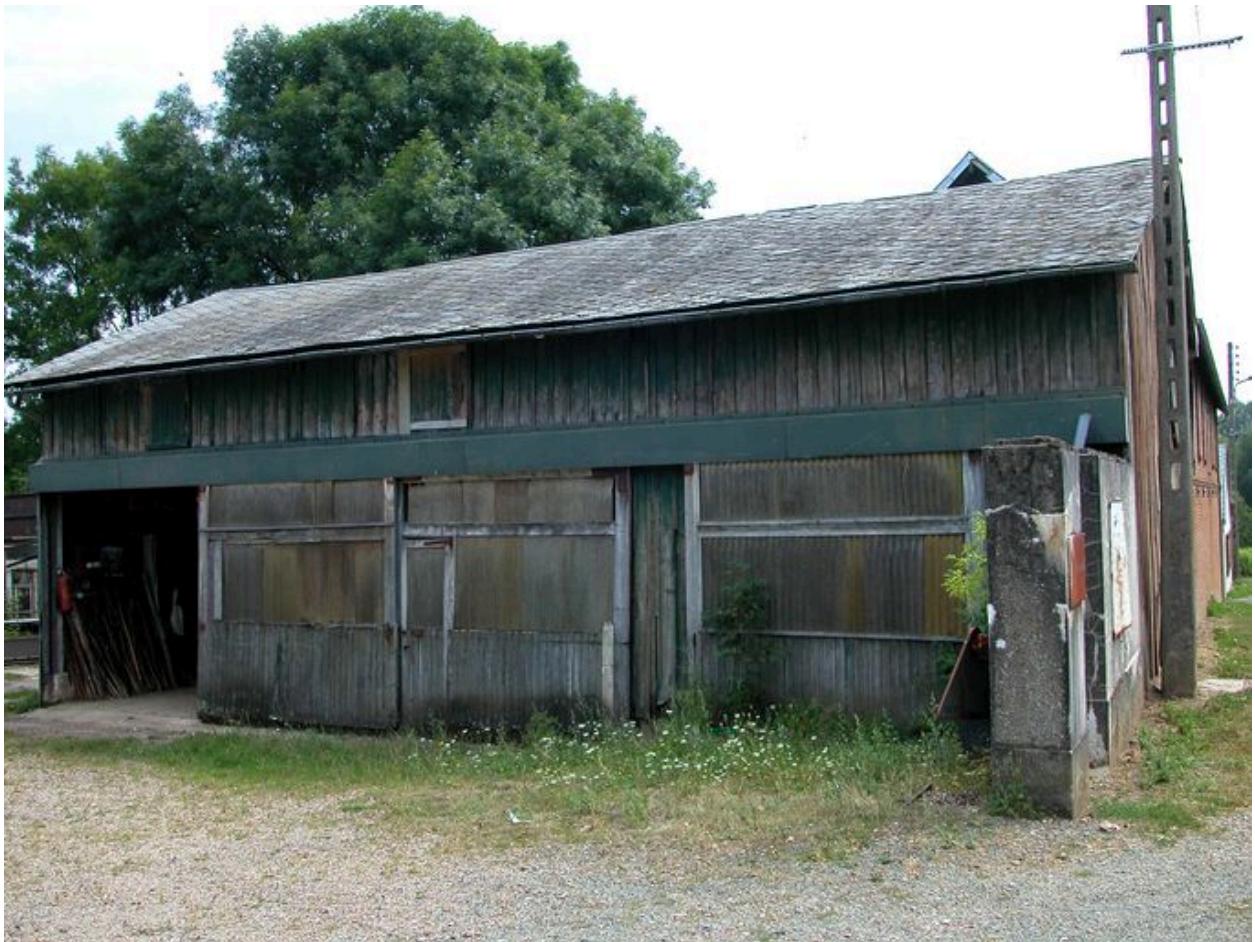
Remise agricole, façade est sur cour.
