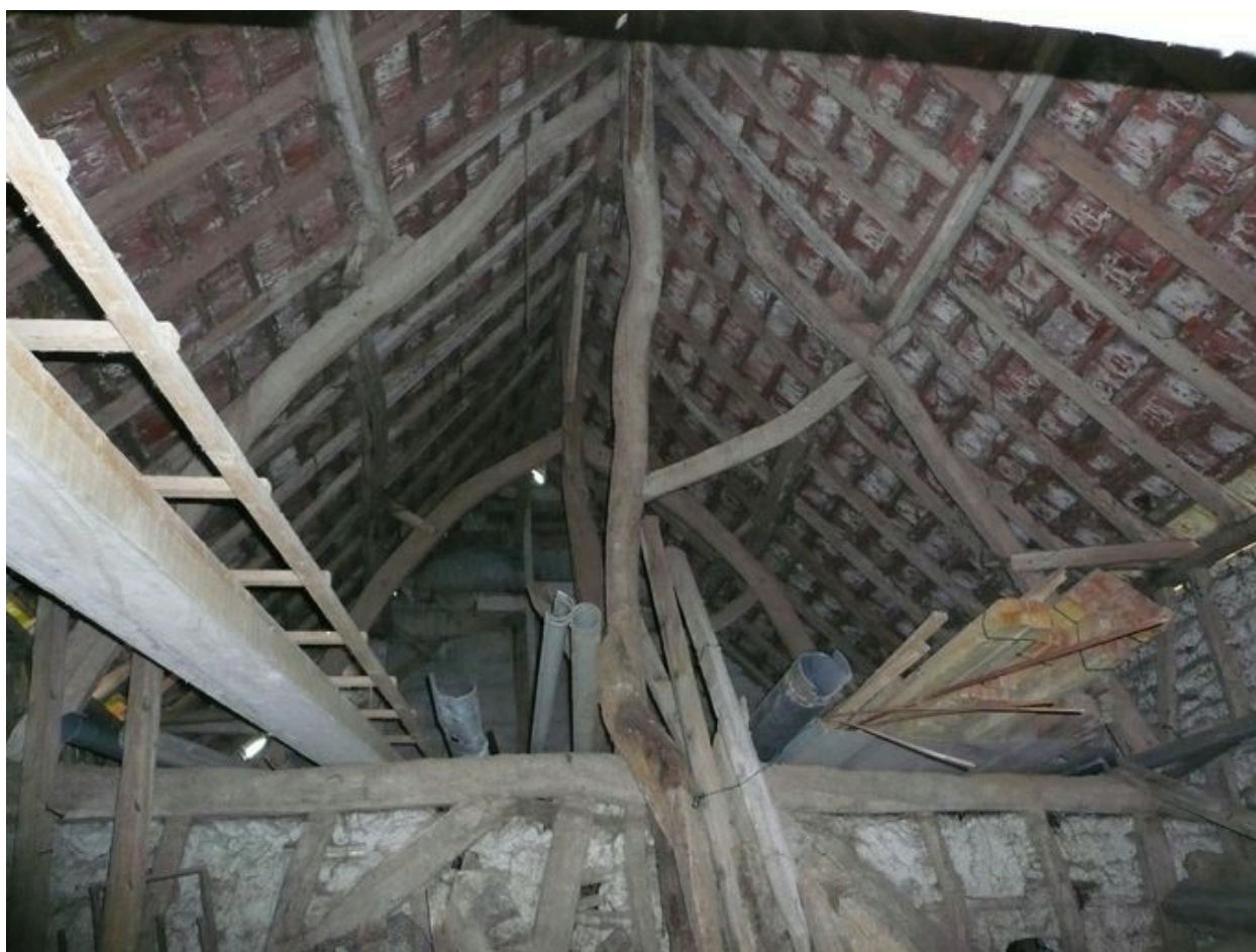
Vue détaillée d'une ferme de la grange.
