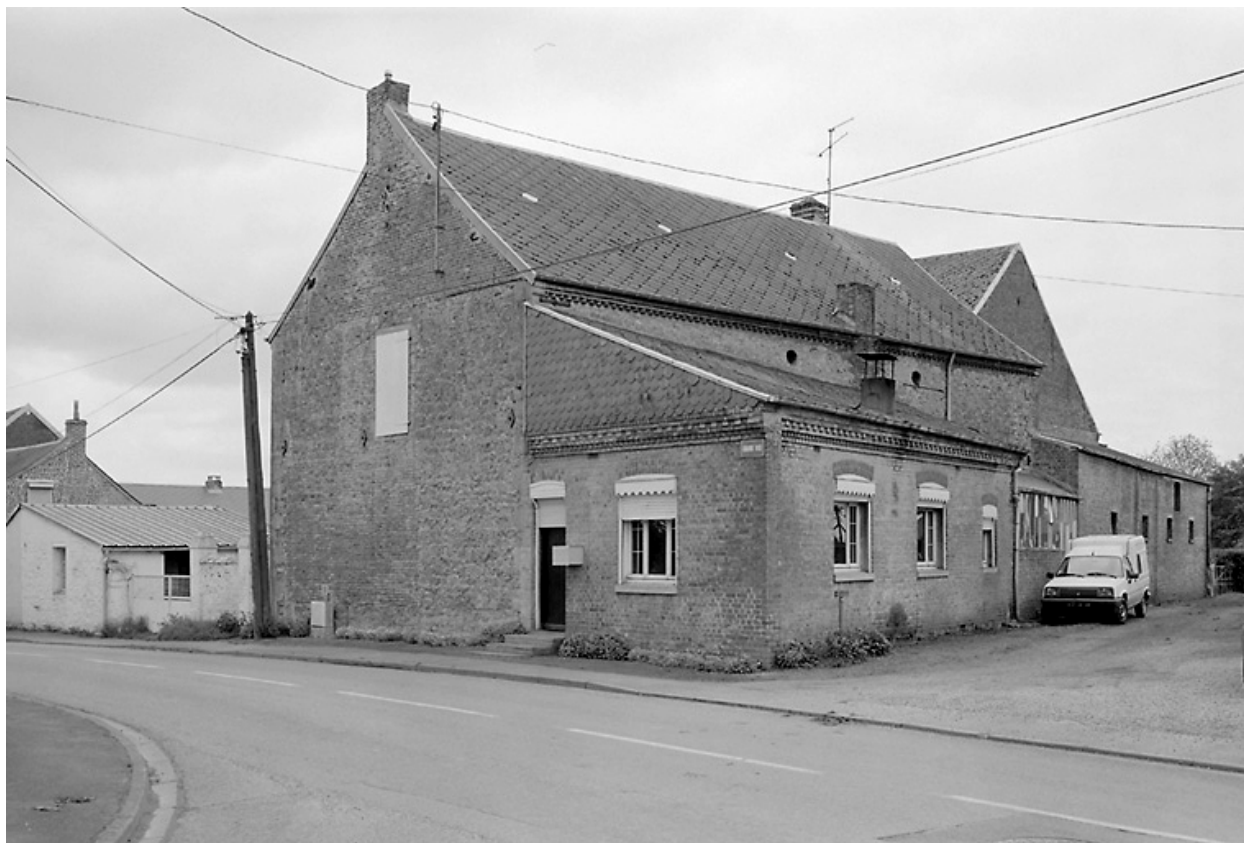
Vue de l'élévation postérieure du logis.
