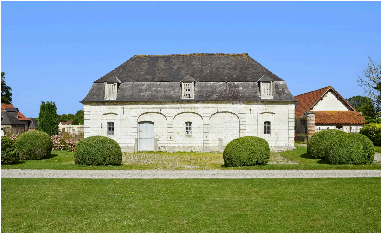
Façade sur parc du pavillon ouest à usage d'écurie pour la ferme.
