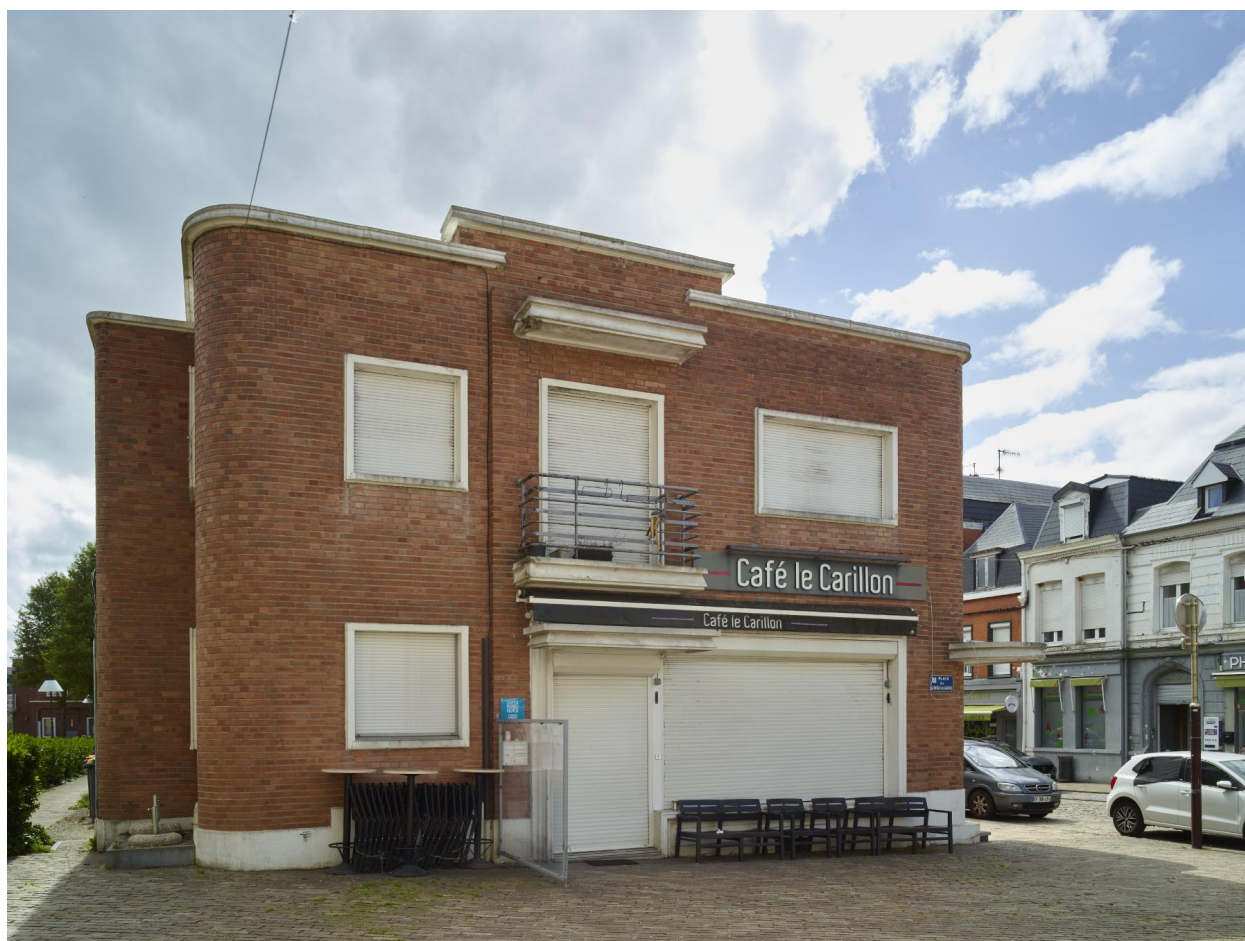
Maison - 1, rue Fournier : toit-terrasse à l'extrémité d'un rang, Seconde Reconstruction.
