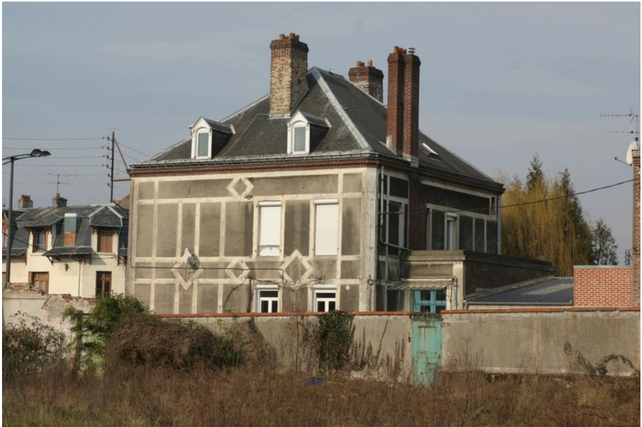
Ancien logement patronal de la minoterie vu depuis l'ancienne cour de la filature Tournon.
