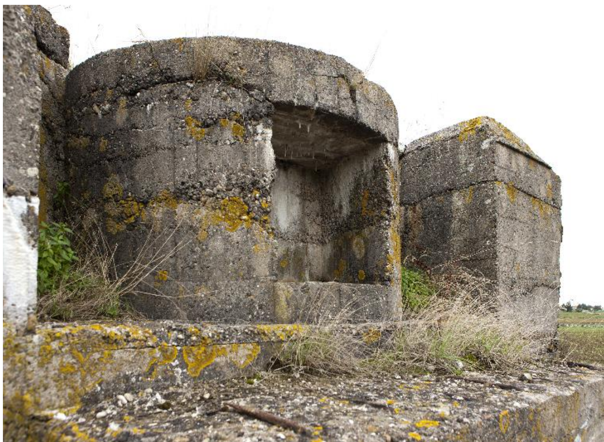
Vue antérieure, détail du support de mortier avec sa niche à munitions
