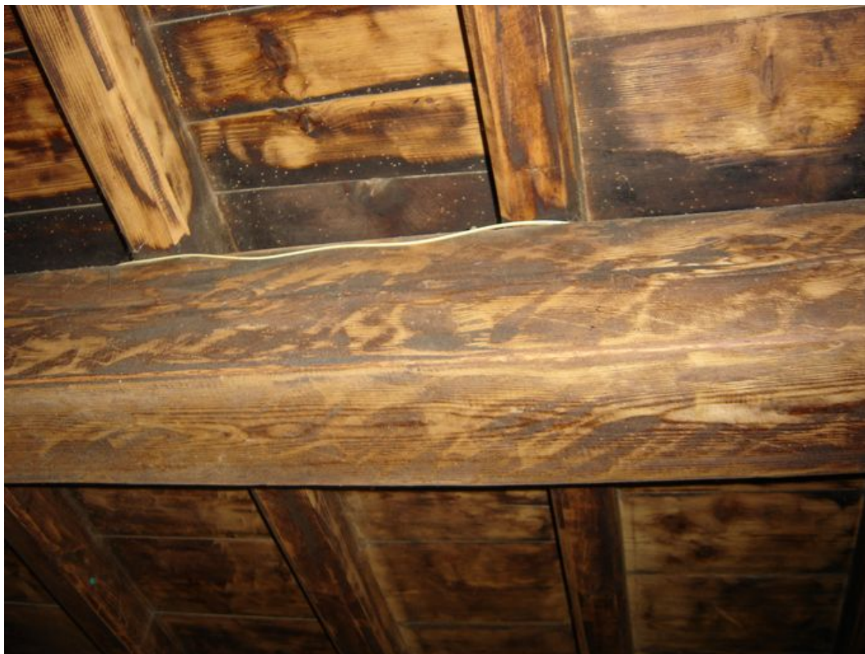
Vue du plafond de la salle d'été.
