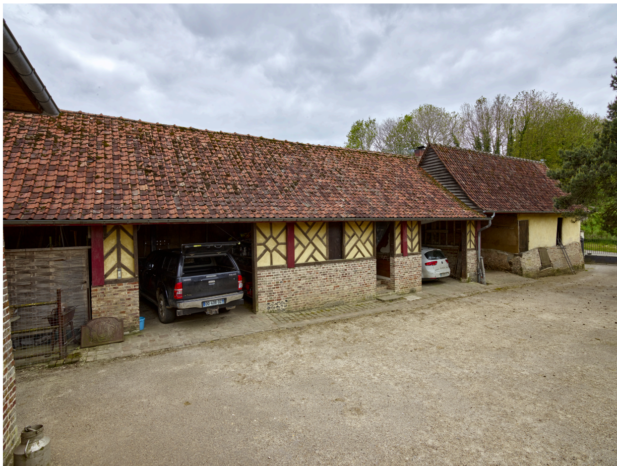
Vue des granges, depuis la cour.
