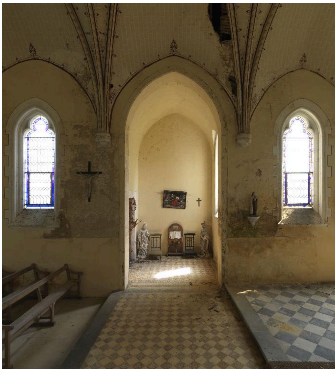
Vue de la chapelle nord.
