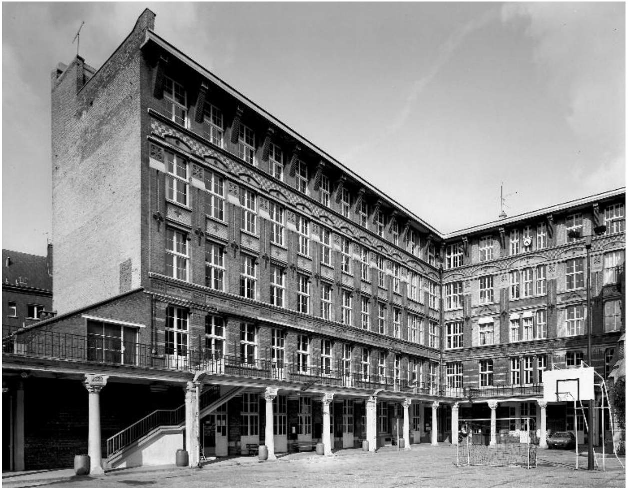
Vue des façades sur cour bâtiments.
