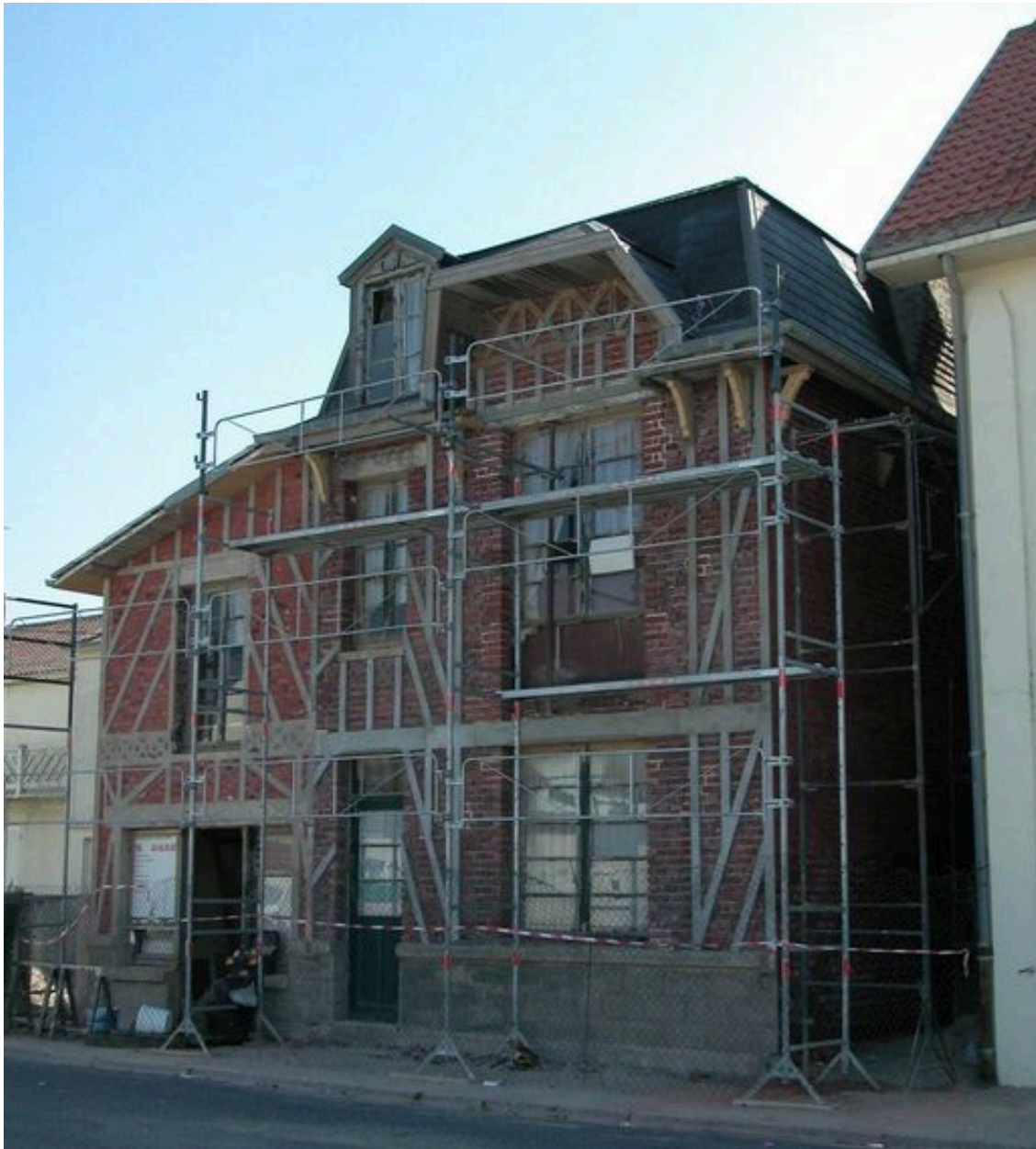
Vue d'ensemble de la maison principale en cours de restauration, 2003.
