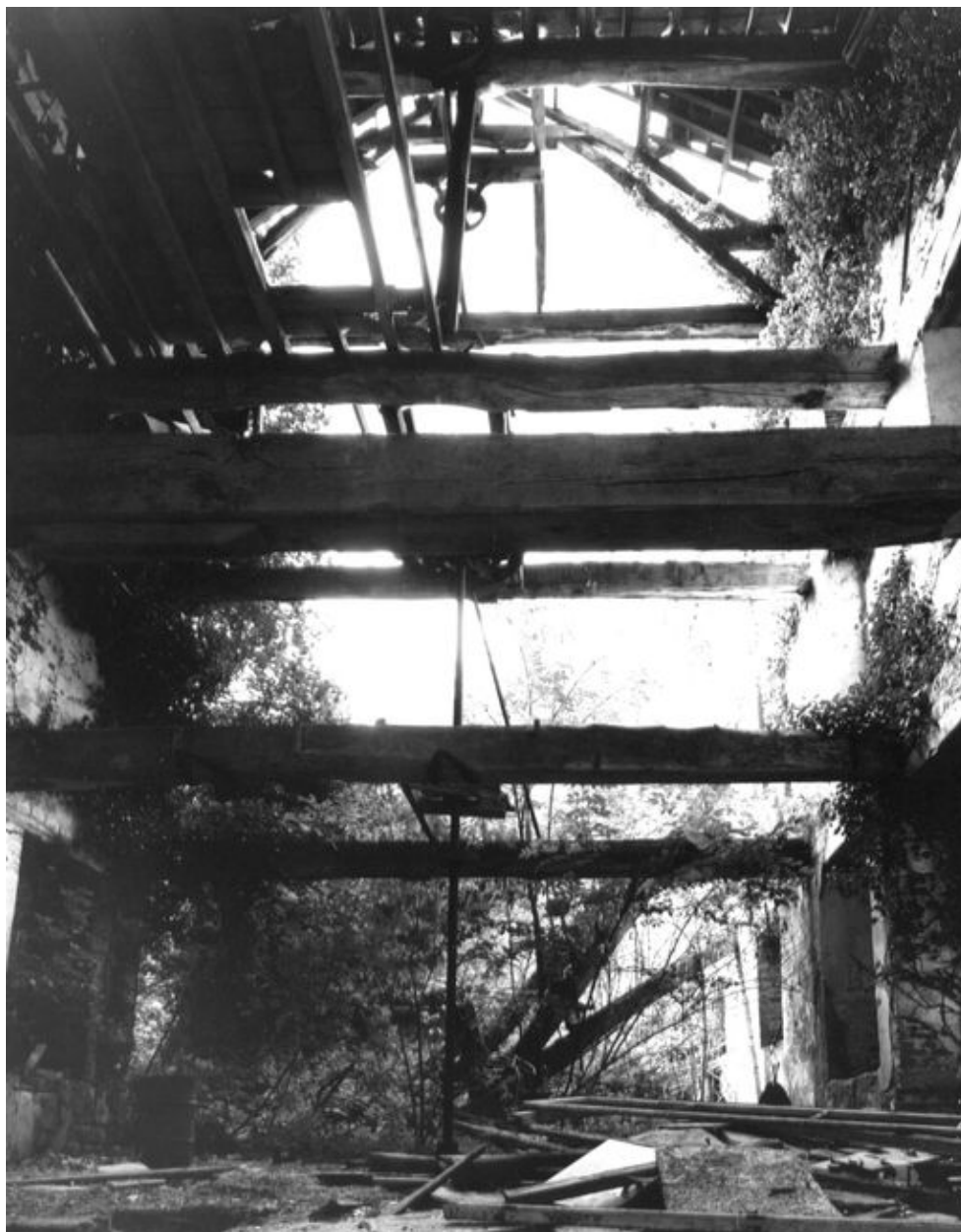
Elévation intérieure du moulin, du rez-de-chaussée aux combles.
